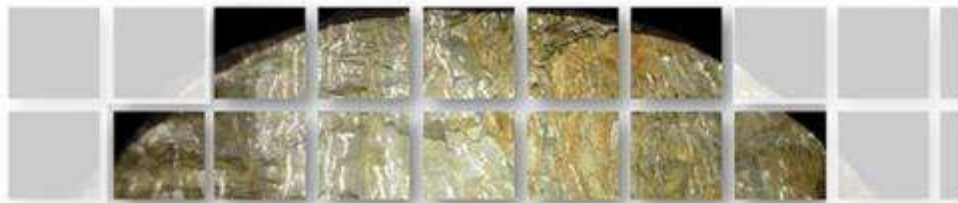
AlexNet(※3)による切羽の評価領域（分割数は撮影時の画素数によって異なります）
